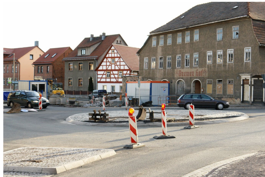
Abb. 6: Umbau Knoten zu Kreisverkehrsplatz 2007 (Quelle Emch + Berger GmbH)
