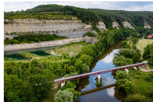
Radwegbrücke über die Werra (© Eisenach-Wartburgregion Touristik GmbH, Foto: Christian Heilwangen)
