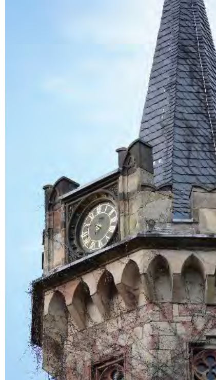
Detail Turm Hirschgalerie
