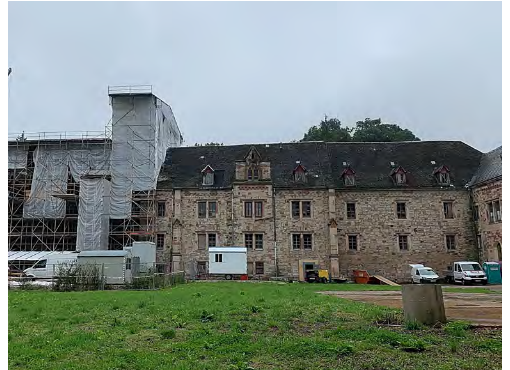
Kirchgalerie, Ansicht von Norden
