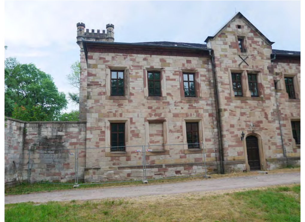
Teil des Gebäudes, Ansicht von Süden
