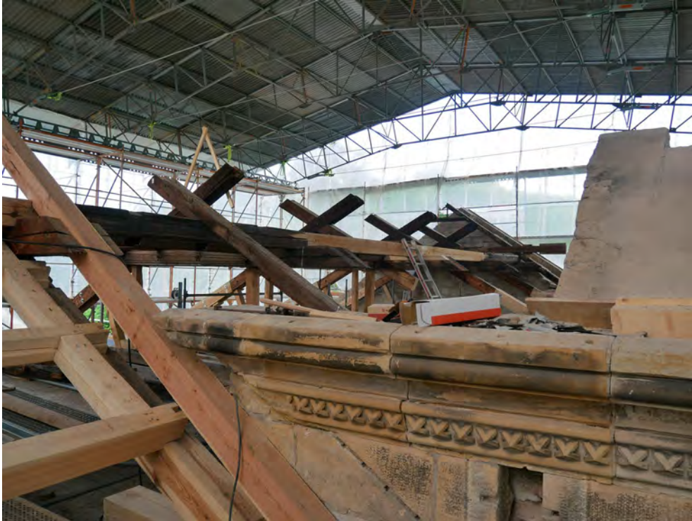
Baustelle, Dach der ehemaligen Schlosskapelle
