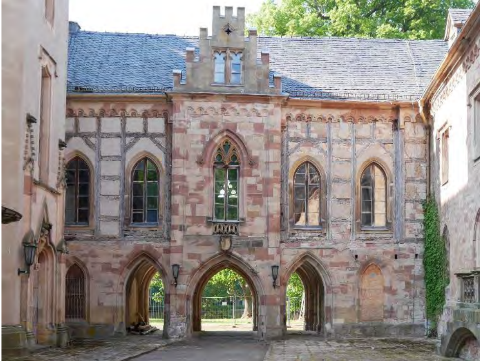
Verbindungsbau von Süden, Ahnensaal im 1. OG
