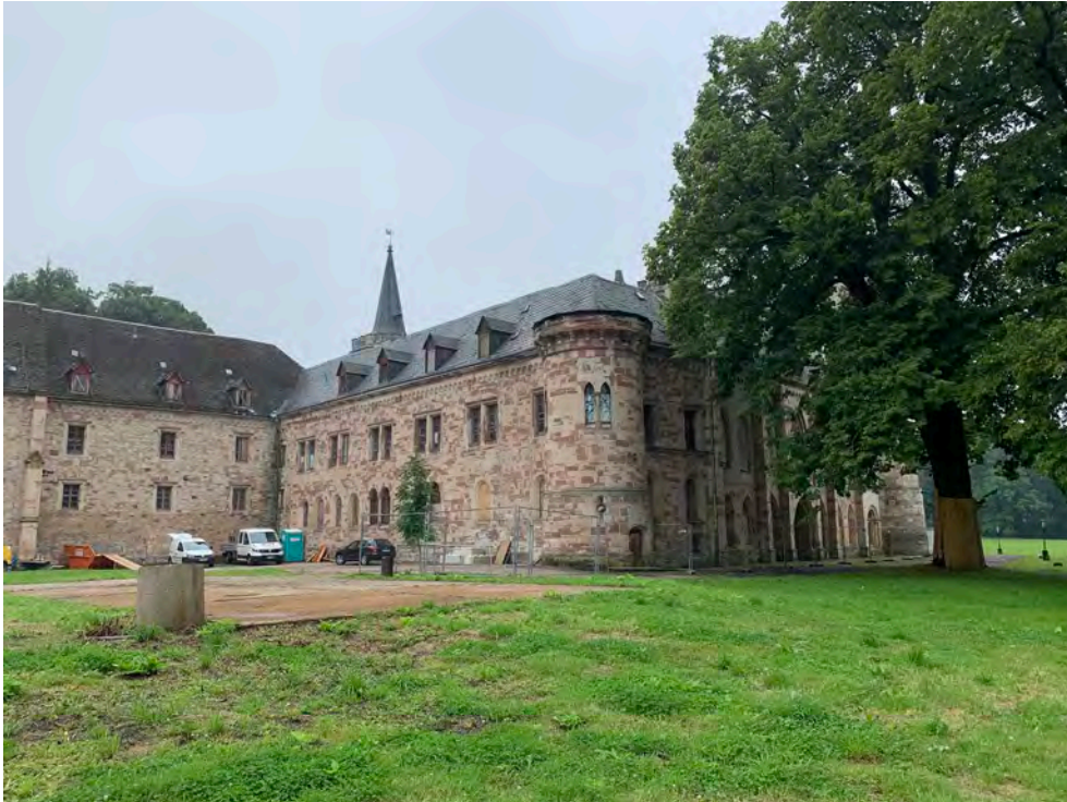
Hirschgalerie, Aufnahme von Nord-Osten
