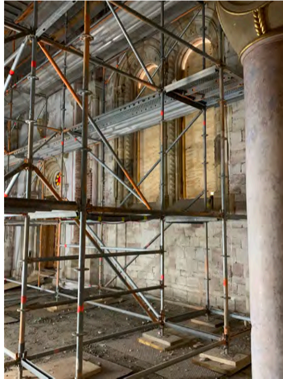
Innenraum ehemalige Kapelle
