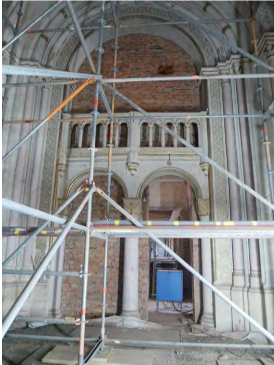
Innenraum Kapelle Blick zur Kirchgalerie und Herzogloge im OG
