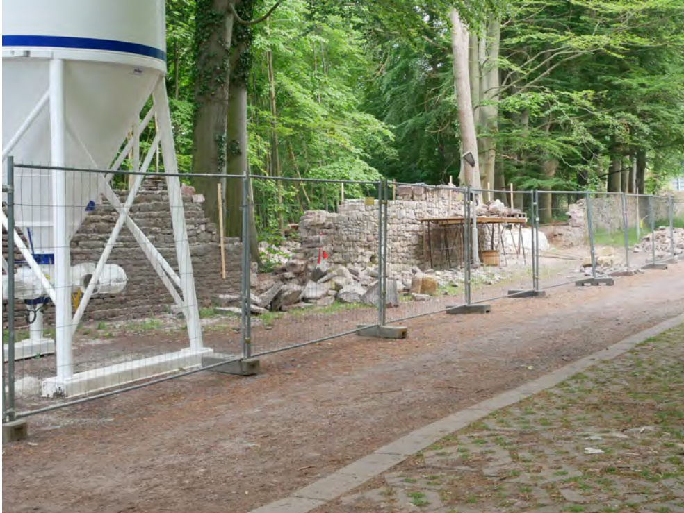
Mauer auf westlicher Parkseite
