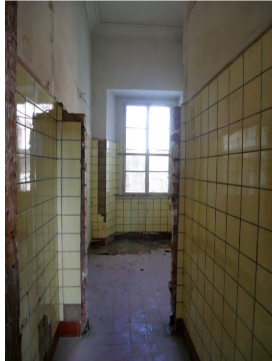
1. OG, Blick in ehemaliges Badezimmer
