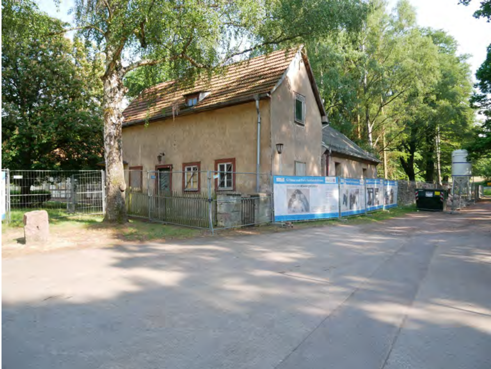
Pförtnerhaus, Blick vom Parkplatz
