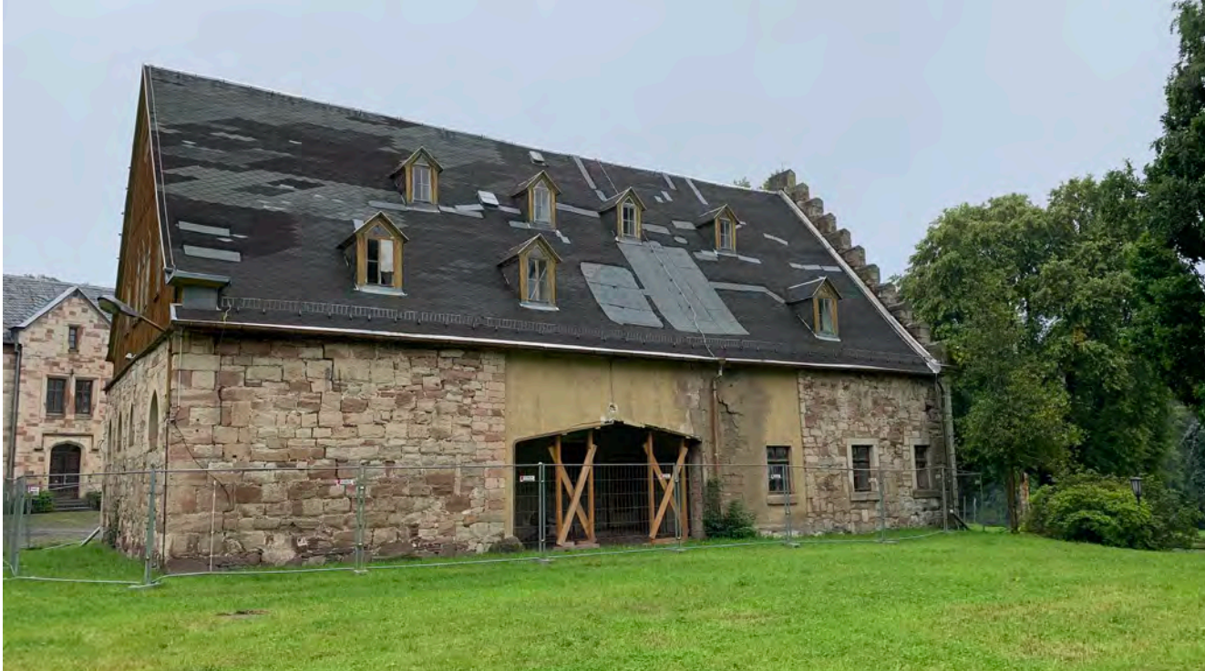
Marstall, Ansicht von Osten
