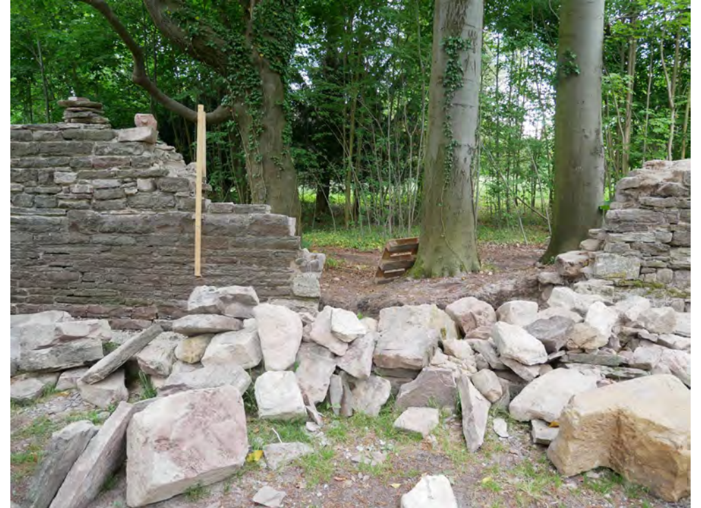
Mauer auf westlicher Parkseite
