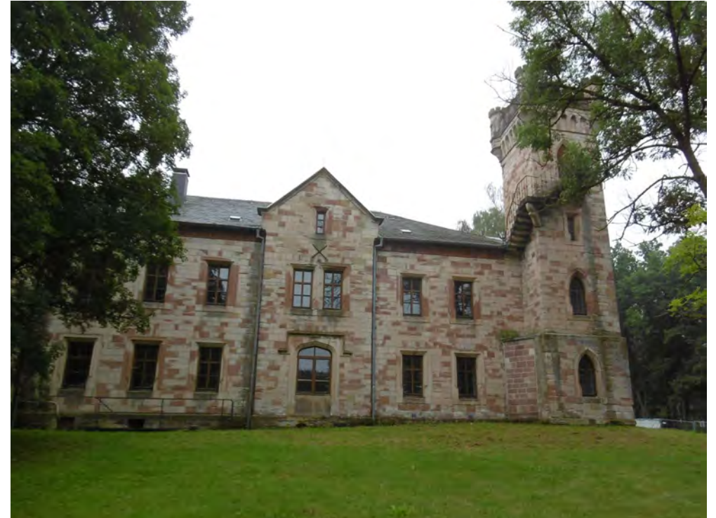
Teil des Gebäudes, Ansicht von Norden
