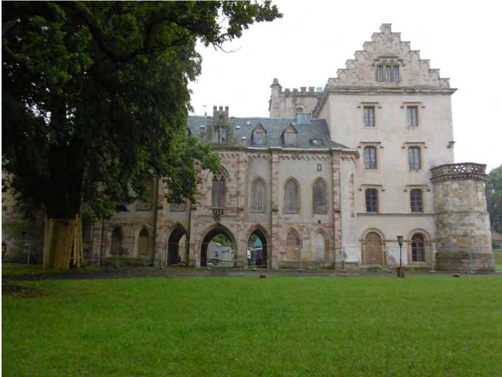
Verbindungsbau von Norden, Ahnensaal im 1. OG
