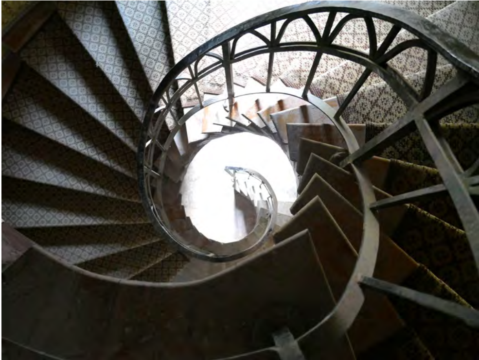
Wendeltreppe im Turm der Hirschgalerie
