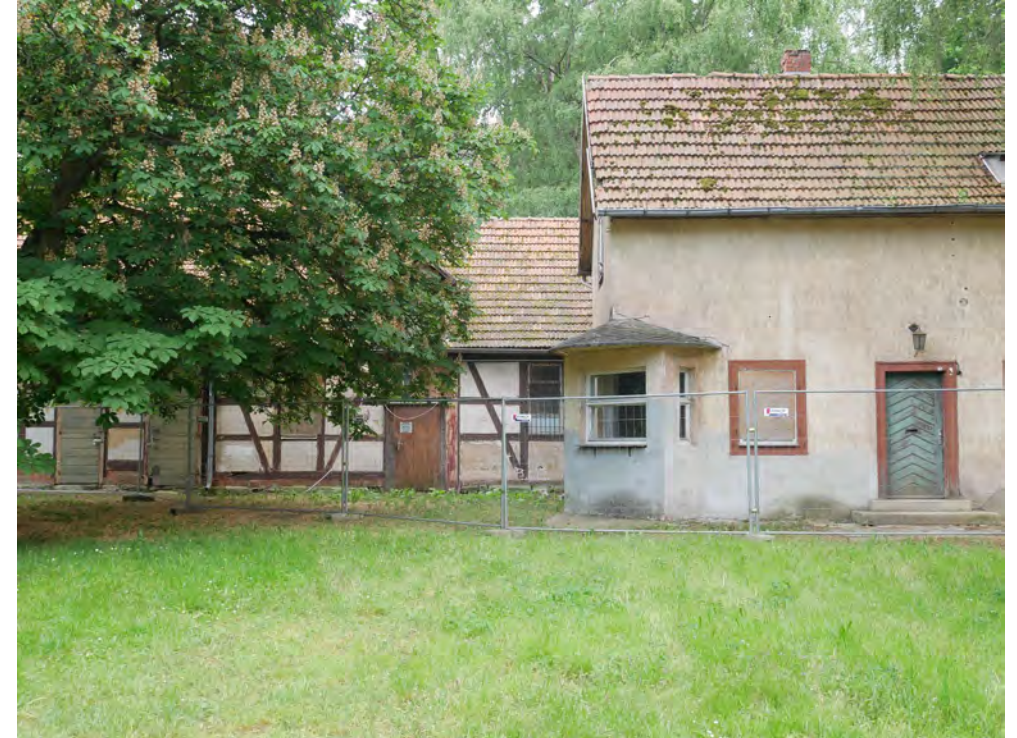
Pförtnerhaus, im Hintergrund Stallgebäude
